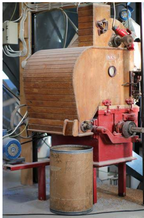
Putsmaskin på Överängs kvarn som slipar spannmålen, det vill säga tar bort groddar och kli med mera. Foto: Alexandra de Haas.
